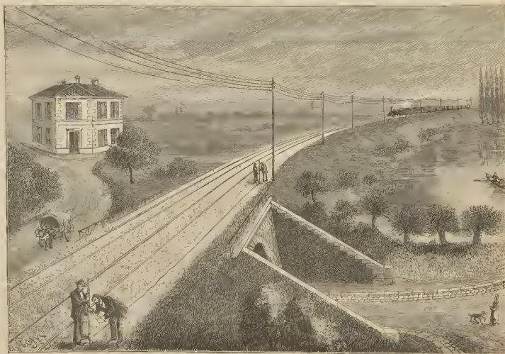
Fig. 2. - Nivelación de una línea de ferrocarril con el nivel de largo alcance
